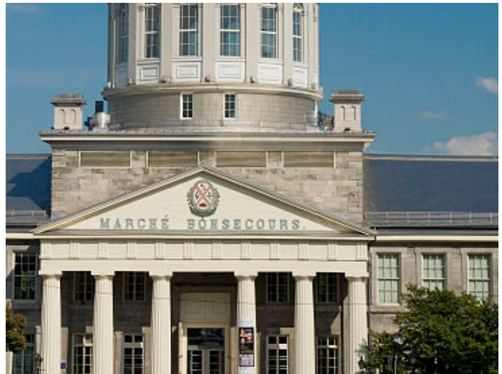
Le langage de l'architecture classique a été utilisé pour le Marché Bonsecours (Vieux-Montréal). Architecte: William Footner, 1844
